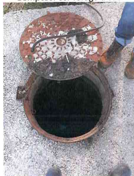
Point de prélèvement pour analyse de la qualité de l'eau (accès difficile, profondeur environ 2m)
