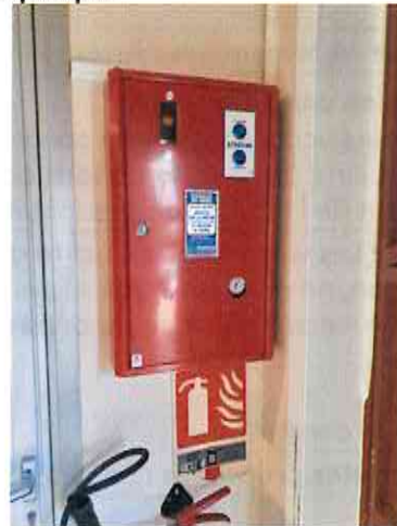
Commande manuelle des dispositifs de désenfumage (usine) - cartouche de gaz et air comprimé
