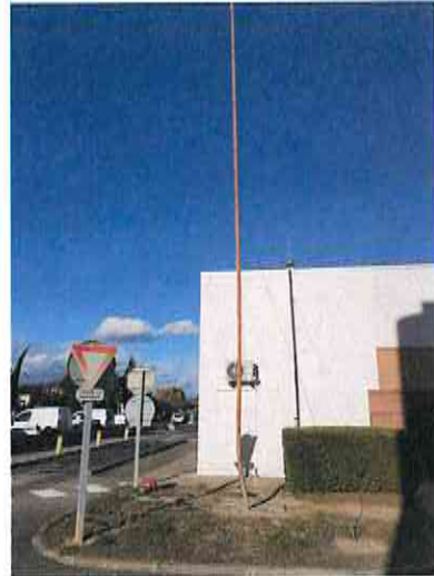
Parafoudre 2, sur mât (compteur d'impact défectueux)
