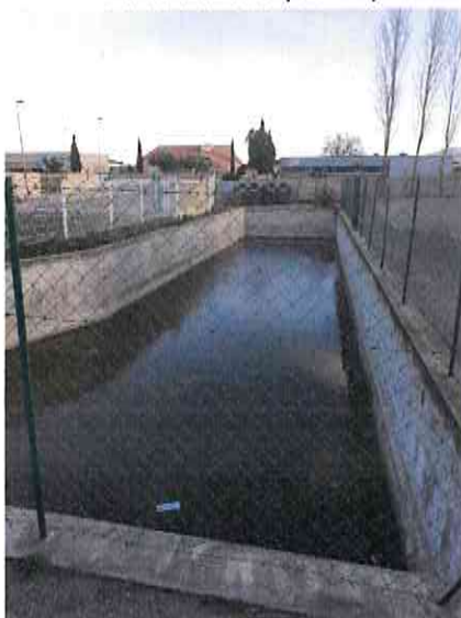
Rétention des eaux d'extinction incendie
