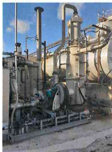
Unité de traitement des gaz et odeurs provenant des événements des cuves de bitumes
