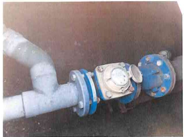
Compteur sur forage d'eau
