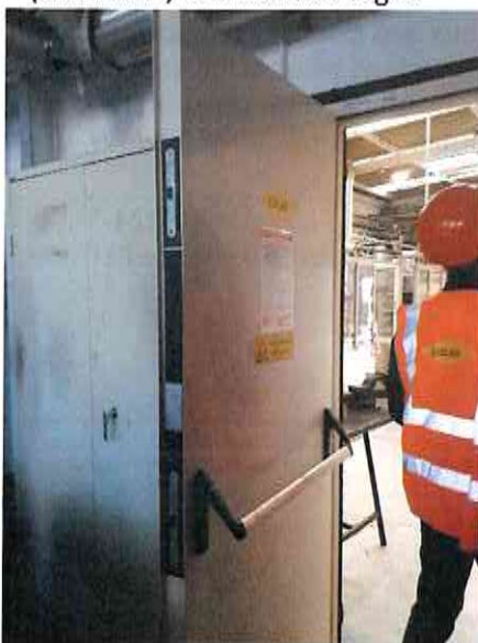
Porte coupe-feu (entre chaufferie et local de fabrication
