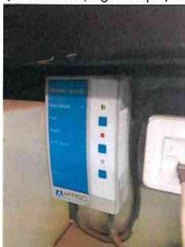
Détecteur de fuite de cuve aérienne de 50 m 3 de la station service (contrôlé le 01/03/2019 par société OSIS)
