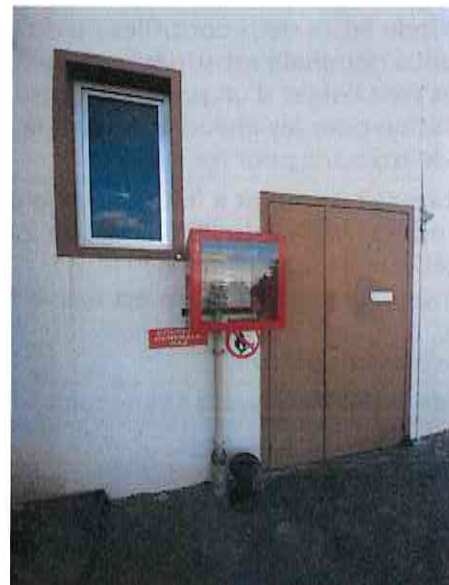
Vanne extérieure, coupure du gaz de la chaudière
